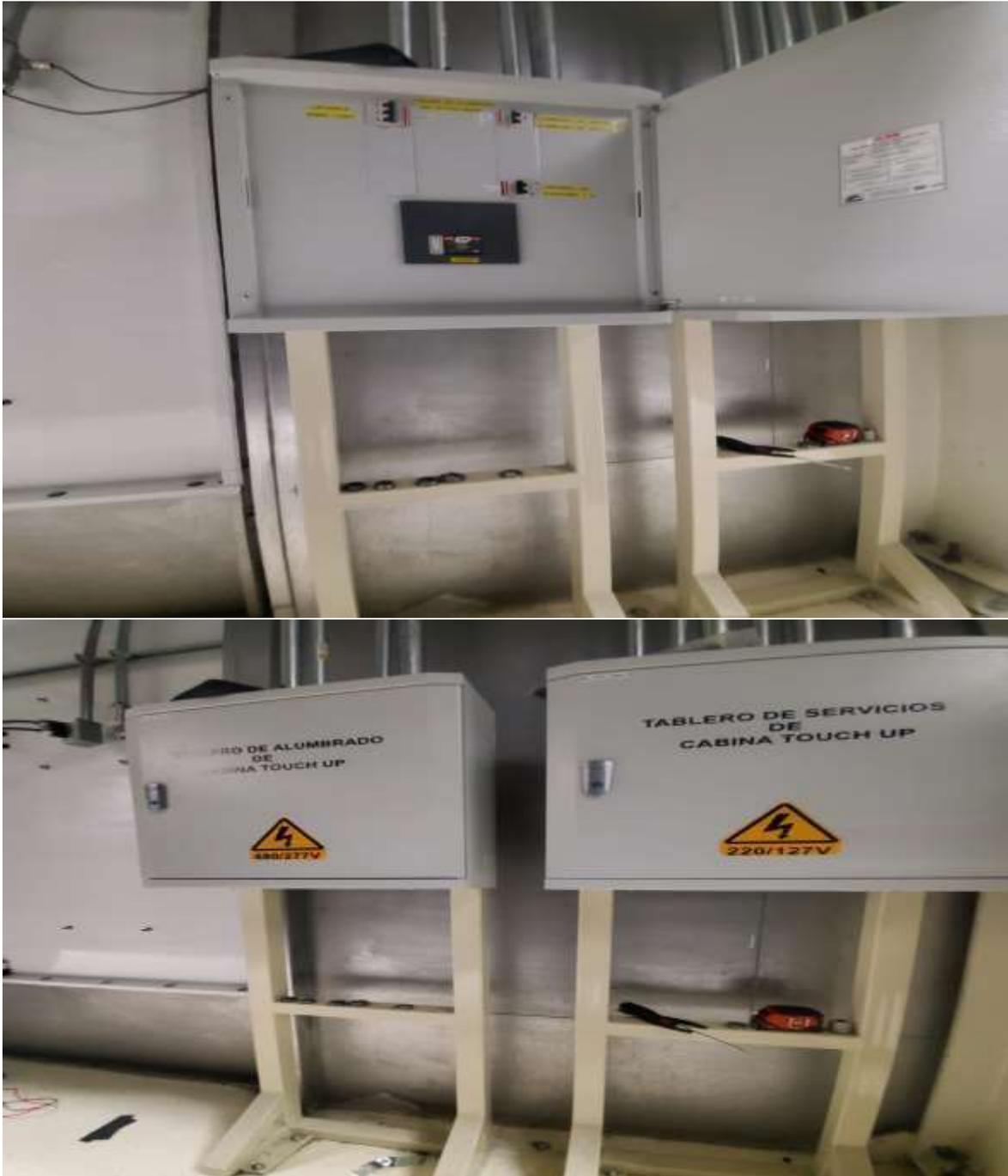
*Ilustración 48 tableros de control general de la cabina touch up*
